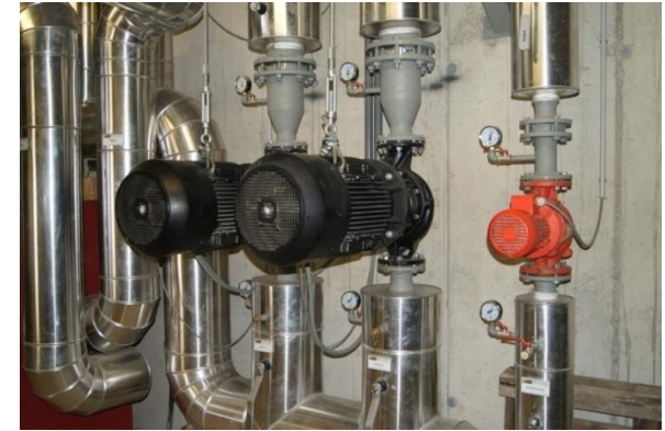
Doppelte Netzpumpen bringen Betriebsicherheit
